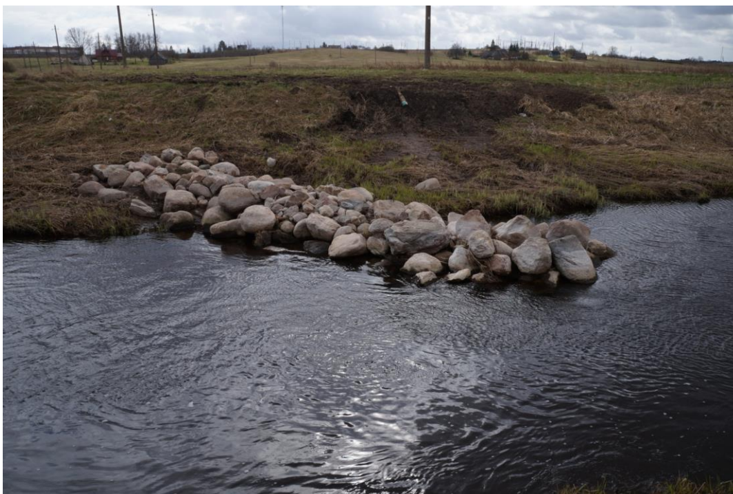
5 pav. Įrengta būna Vyžuonos upėje (Rokiškio r.) (J. Samosionoko nuotr.)
