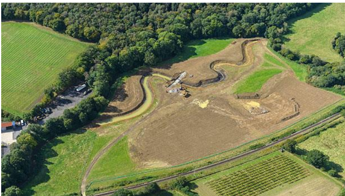
4 pav. Pilnas vagos atstatymas – upės vingio suformavimas sunkiąja technika [3]
