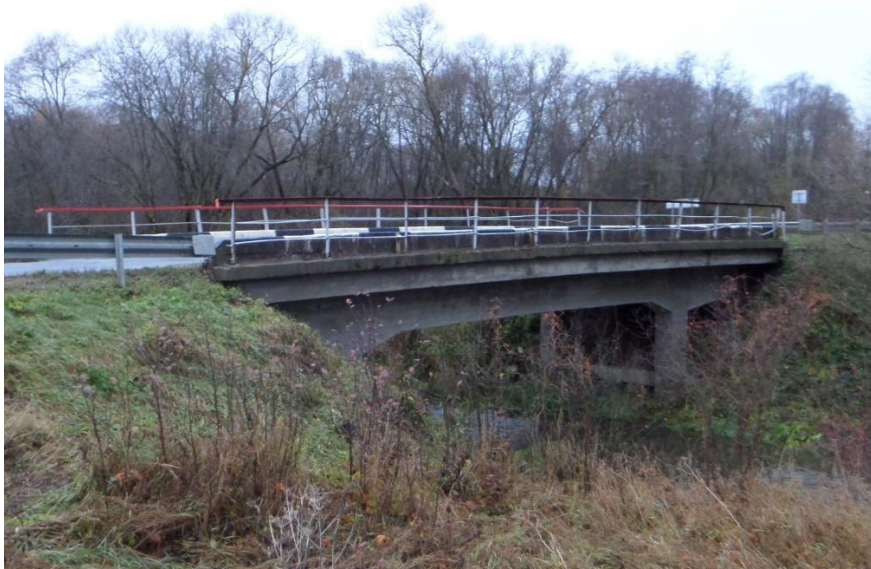
4.1. pav. Esamo tilto vaizdas
