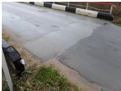
4.2. pav. Nėra deformacinių pjūvių tilto galuose
