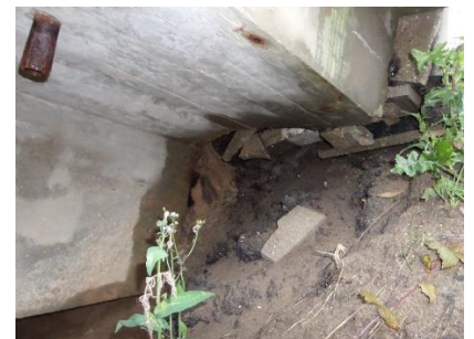
4.3. pav. Dėl ramtų nebuvimo slenka kūgiai ir drėksta perdangos konstrukcija
