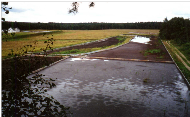
40 pav. Dumblas supiltas į iš polietileninės plėvelės paruoštus aptvarus.
