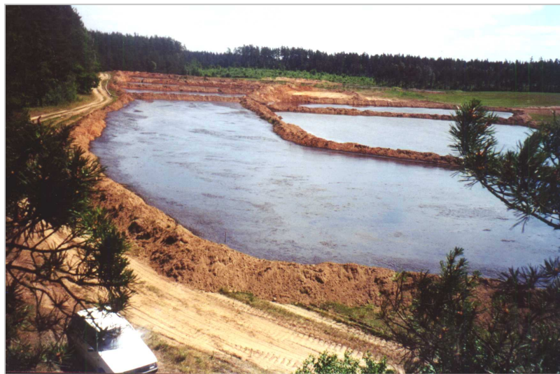
39 pav. Ant lauko įrengti grunto pylimų sėsdintuvai
