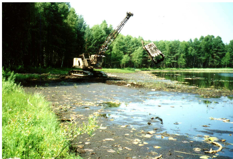
33 pav. Ežero pakrančių valymas ekskavatoriumi draglainu ant klojinių
