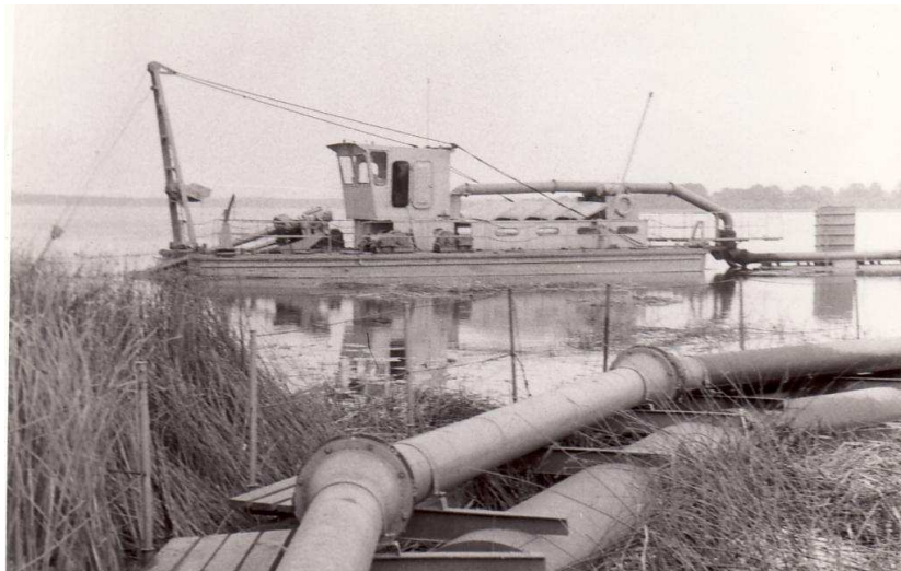
11 pav. Žemsiurbė ZRS – G valo Lėno ežerą 1986 m.
