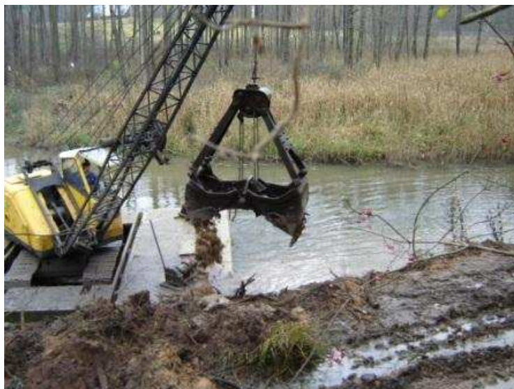
29 pav. Augustavo kanalo kasimo darbai ekskavatoriumi su greiferiniu kaušu.
