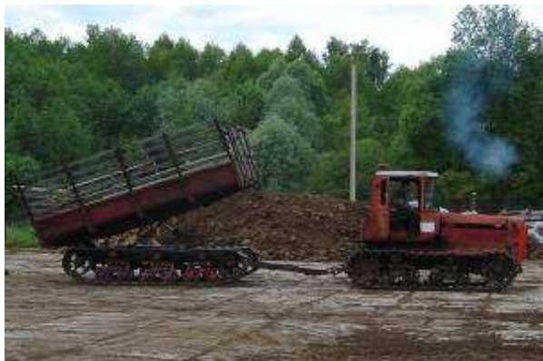
37 pav. Plačiavikšris traktorius DT – 75B su vikšrinė priekaba MTP – 24B iškasto grunto iš pelkės išvežimui.
