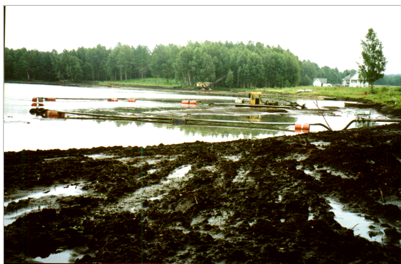
19 pav. LŽŪU Vandentvarkos katedros konstrukcijos žemsiurbė VT – 1 valo Vainieko ežerą
