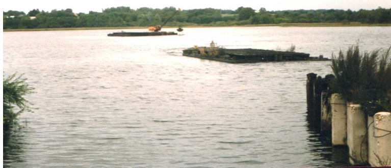
27 pav. Ežero valymas ekskavatoriumi su greiferiniu kaušu nuo pontonų
