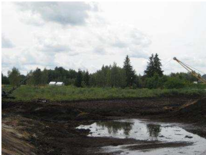
32 pav. Kūdras valymas dviem ekskavatoriais draglainais, valdančiais vieną kaušą (vienas kasa, kitas tuščią kaušą traukia į kasvietę)
