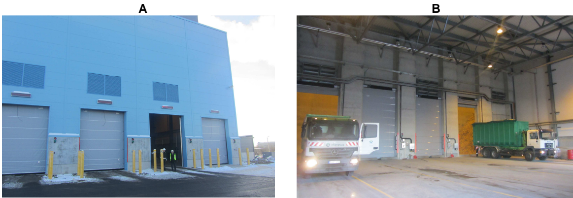
2.7 pav. Klaipėdos termofikacinės jėgainės kuro priėmimo patalpos išorinis (A) ir vidinis (B) vaizdai
