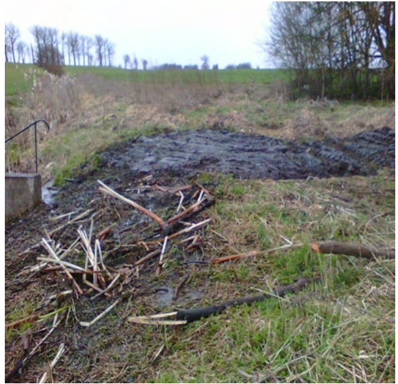
2.2.4.2 pav. Sąnašų valymas ties šlapynės įtekėjimo slenksčiu
