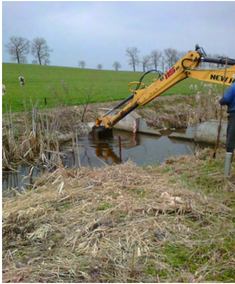
2.2.4.2 pav. Sąnašų valymas ties šlapynės įtekėjimo slenksčiu
