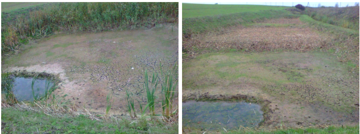
2.3.1.4 pav. Išdžiūvęs sedimentacijos tvenkinėlis Tv 3 rugpjūčio pabaigoje. Rugsėjo 30 d. iš tvenkinėlio pašalinta augalija (joje buvo sukaupta daugiausia maistmedžiagių, lyginant visų tvenkinėlių augalijas).
