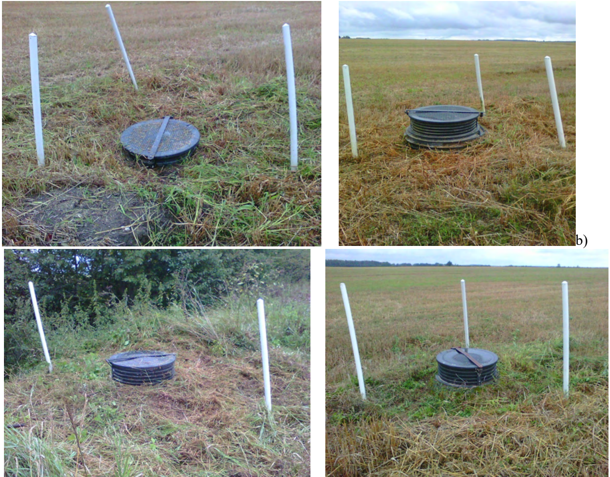
2.6.4.1 pav. Drenažo šulinėliai po augalijos pašalinimo
