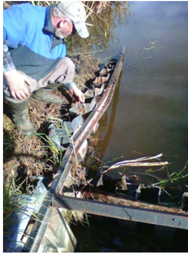
2.2.4.2 pav. Šlapynės ištekėjimo slenksčio remonto darbai
