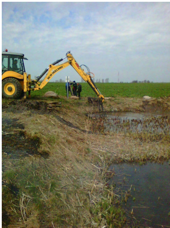
2.4.1.2 pav. Nešmenų pašalinimas sedimentacinio tvenkinėlio Tv 1 giliojoje dalyje 2020 m. balandžio 9 d.
