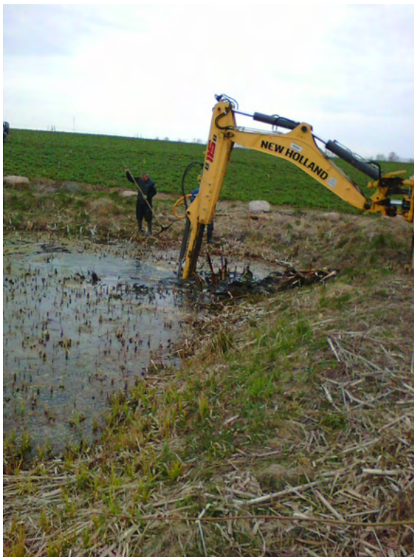
2.4.1.2 pav. Nešmenų pašalinimas sedimentacinio tvenkinėlio Tv 1 giliojoje dalyje 2020 m. balandžio 9 d.
