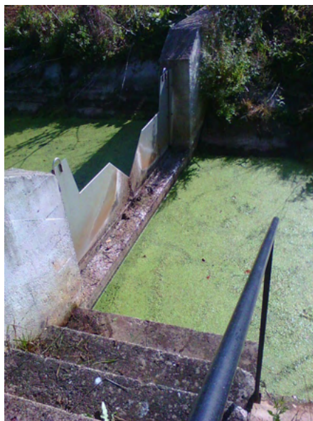
2.1.1.3 pav. Nusekęs vandens lygis ties įtekėjimo ir ištekėjimo nuopylomis rugpjūčio 10 d.
