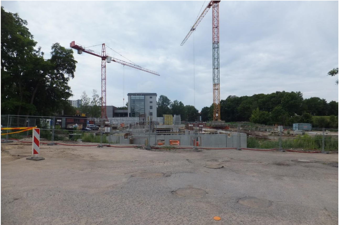
26.1 pav. Daugiabučių (Bangų g. 7) statyba šalia planuojamos Bastionų gatvės (fotografuota 2017-08-03)
