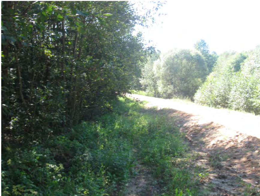
5.2.2 pav. Greta Miško g. įrengtas ant kelio dangos susidarančių paviršinių nuotekų surinkimo ir nuvedimo griovys
