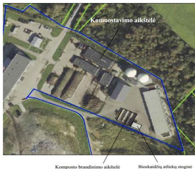
Pav. 2 Esama situacija prieš rekonstrukciją
