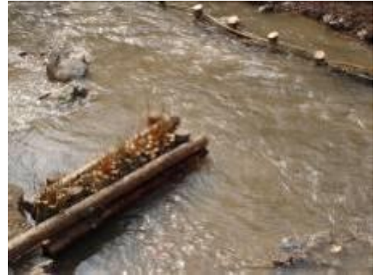
II.2.26. pav. Būnos konstrukcija iš rąstų ir karklų gyvakuolių (Modling upė (Austrija)) (Buhnenbau..., 2005)
