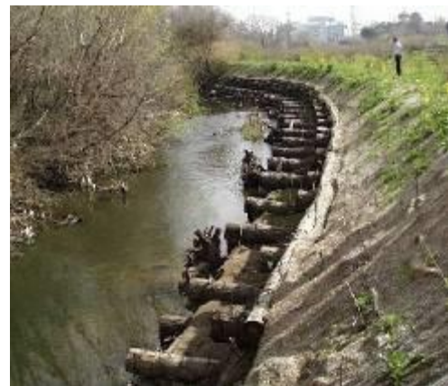
II.2.27. pav. Rąstų rentinio įrengimo schema ir panaudojimas pakrantės zonoje (Soil..., 1991).
