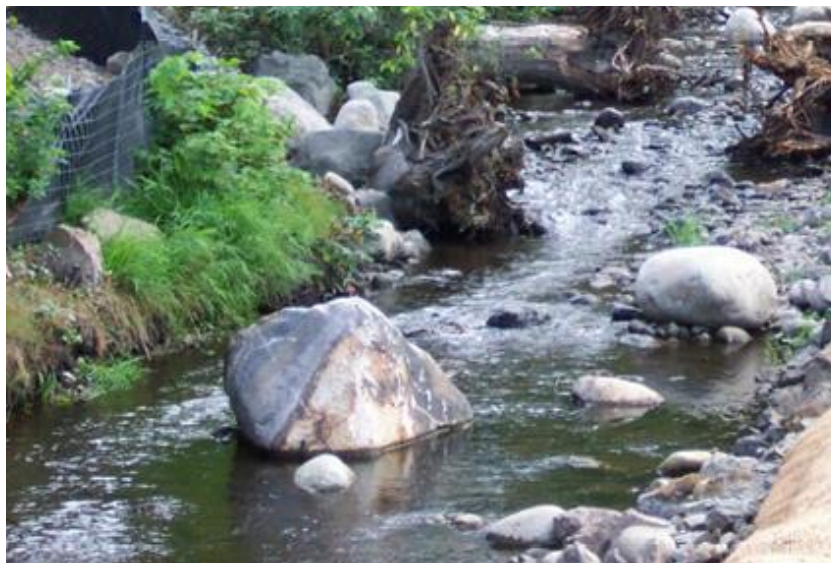
II.7.2.1. pav. Pavienių akmenų išdėstymas upės vagoje.
