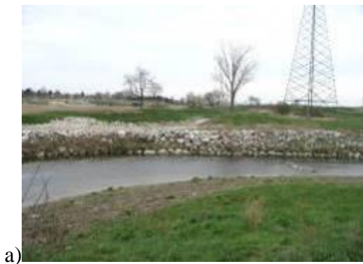
II.2.18. pav. Krantų tvirtinimas akmenų metiniu a) Liesing upė (Austrija) b) Drau upė (Austrija)
