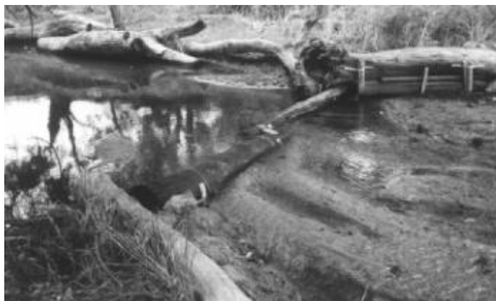
II.2.20. pav. Slenksčių suformavimas vagoje iš rąstų Pietų Dandalup upėje (Australija) (Stream..., 2001)
