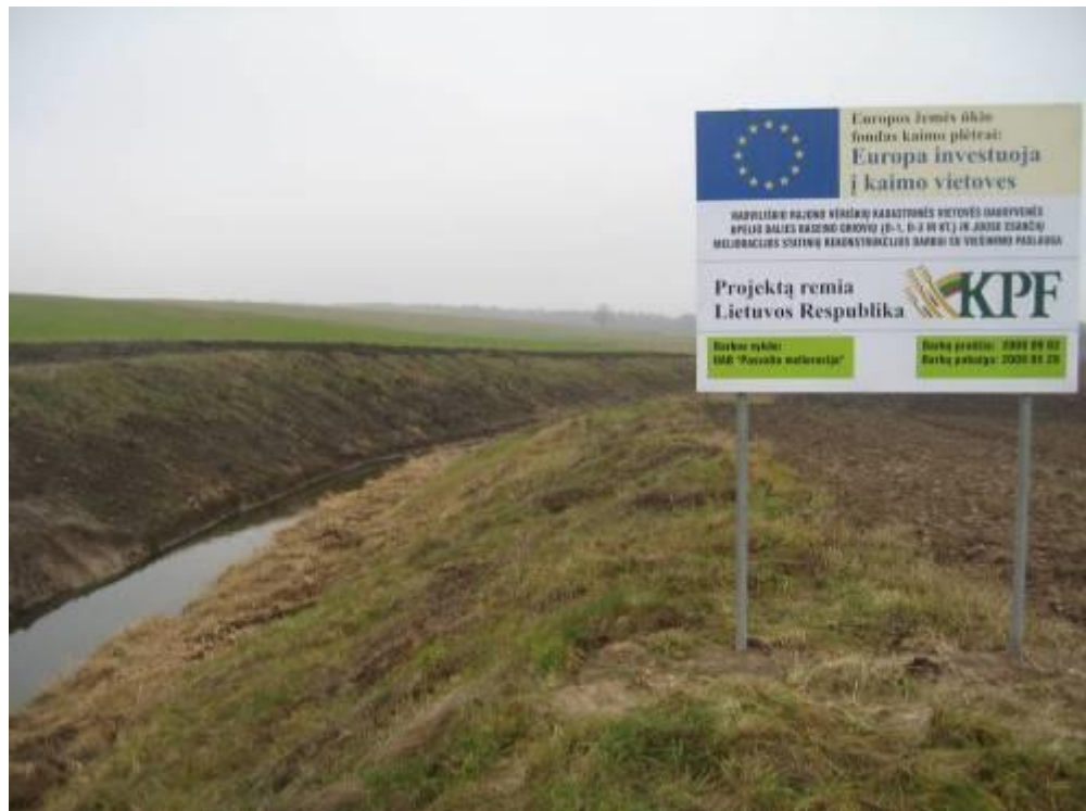
II.2.1. pav. Ištiesinto ruožo rekonstrukcijos darbai (Daugyvenės upė) (R. Gegužio nuotr.)
