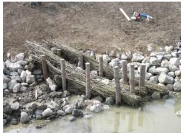
II.2.23 pav. Žabinių konstrukcija ir panaudojimas renatūralizuojant Liesing upę (Austrija) (Ingenieurbiologisches..., 2005)
