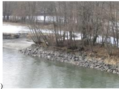
II.2.18. pav. Krantų tvirtinimas akmenų metiniu a) Liesing upė (Austrija) b) Drau upė (Austrija)
