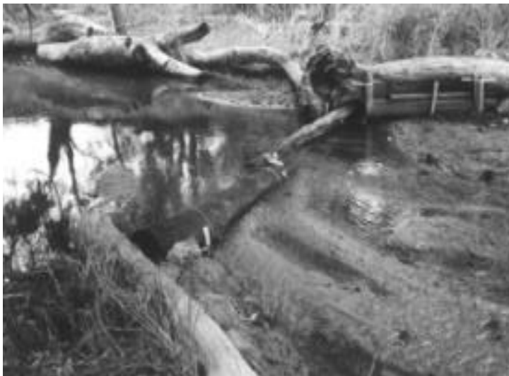
II.7.2.5. Slenksčių suformavimas iš rąstų.
