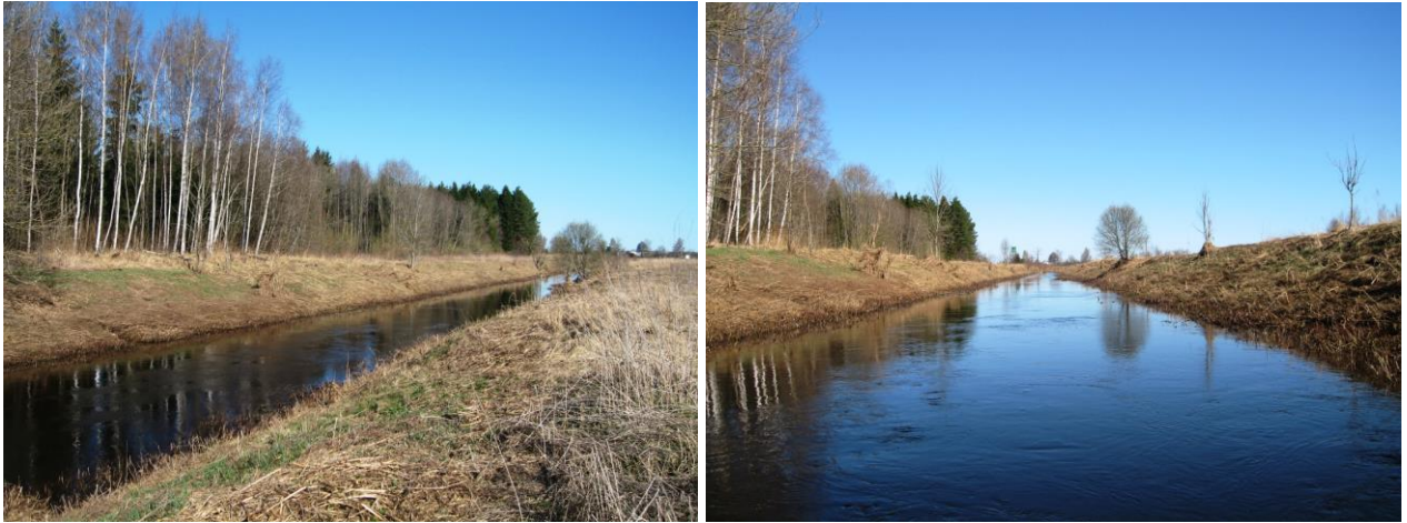
II.6.11. pav. Nevėžio upės tiesintas ruožas, tekantis pamiške (R. Gegužio nuotr. 2010 04).
