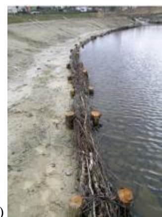
II.7.2.6. pav. Žabinių panaudojimas vagos formavimui (a) ir krantų apsaugai nuo erozijos (b) (R. Baublio nuotr.)
