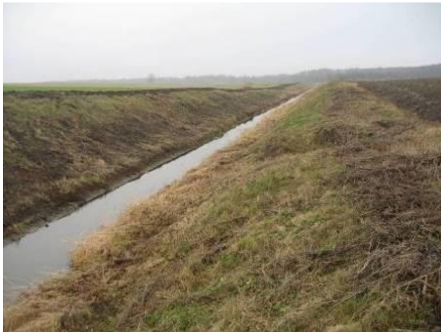
II.1.6. pav. Ištiesintas upės ruožas (Daugyvenės upė), kuriame ištiesinimo metu pašalinta vagos ir pakrantės augmenija (R. Gegužio nuot.).
