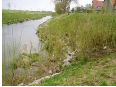
II.2.21. pav. Karklų gyvakuoliai ir jų panaudojimas upelių krantų apželdinimui.
