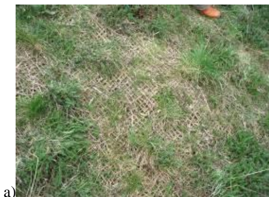
II.2.19. pav. Pakrantės sutvarkymas panaudojant kokoso pluošto tinklą (a) ir akmenų metinį (b) (Jormola, 2006).
