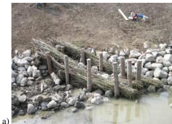
II.7.2.6. pav. Žabinių panaudojimas vagos formavimui (a) ir krantų apsaugai nuo erozijos (b) (R. Baublio nuotr.)
