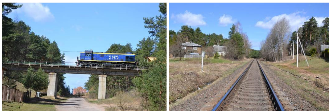
13 pav. Geležinkelis Pažaislio šile (kairėje- viadukas per Kalantos g., dešinėje- geležinkelis ties Buriuotojų g.)
