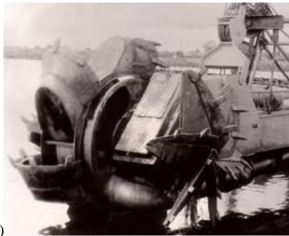
4.8 pav. Žemsiurbė ZGM – 1 – 350 (a) ir rotorinis – kaušinis purentuvas (b) (A.Ciūnio nuotr.)
