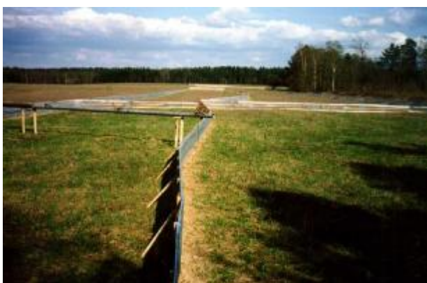
4.6 pav. Sėsdintuvai suformuoti iš polietileninės plėvelės aptvarų (a) ir iš grunto pylimų (b)
