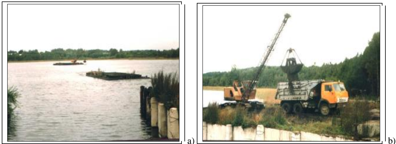
4.11 pav. Ežero valymas ekskavatoriumi draglainu su greiferiniu kaušu nuo plūduru: a) sapropelio kasimas ir transportavimas barža prie krantinės; b) sapropelio iškrovimas iš baržos kitu ekskavatoriumi į autosavivartį (A.Ciūnio nuotr.)
