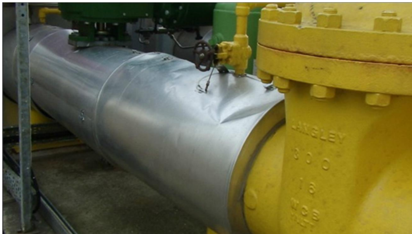
5 pav. Aukšto slėgio vamzdynų izoliavimas
