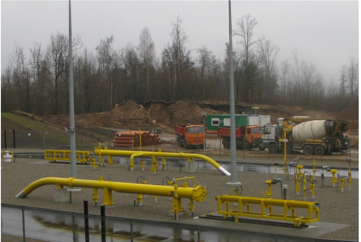
4 pav. Antžeminės kontrolinio įtaiso priėmimo/paleidimo kameros pavyzdys
