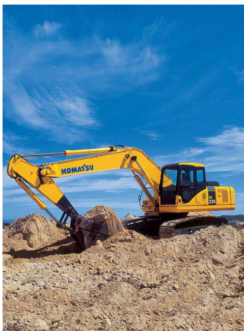
2.5 pav. Žvyro kasimas atvirkščio kasimo ekskavatoriumi Komatsu PC220
