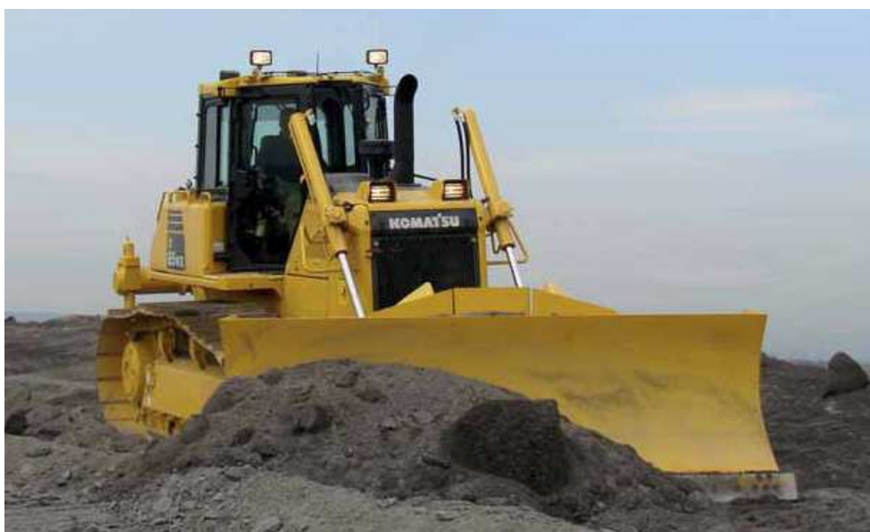
2.2 pav. Buldozerio Komatsu D65 panaudojimas atodangos darbuose
