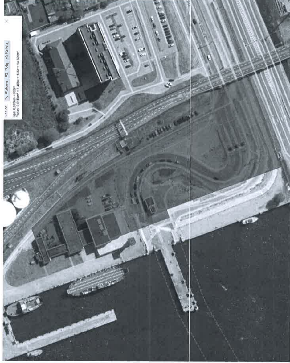
1 pav. AB "Smiltynės perkėla" 1,45 ha teritorija , nuo kurios paviršinės nuotekos surenkamos, apvalomos ir išleidžiamos į Kuršių marias
