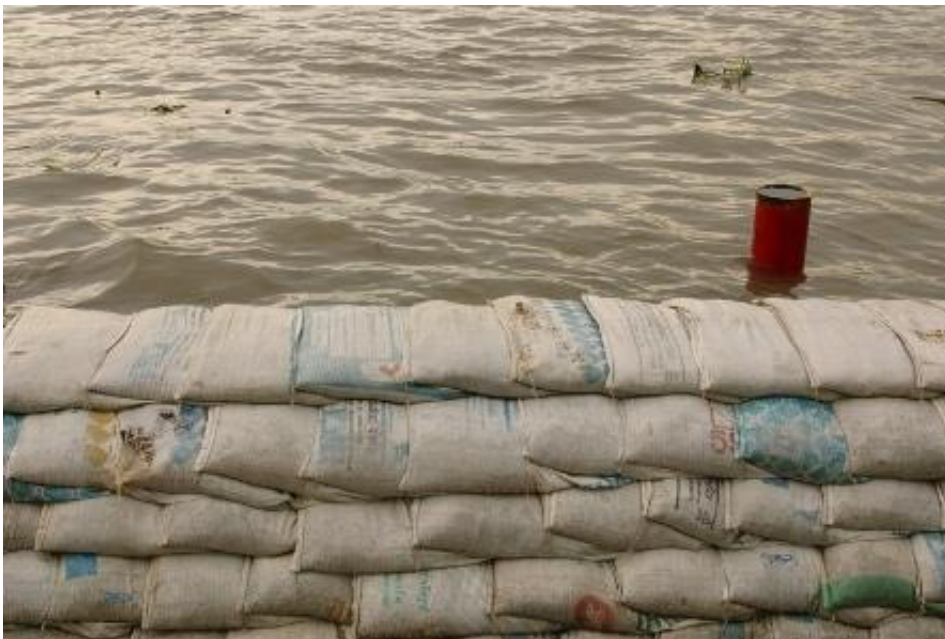
Paveikslas 18. Apsauga nuo potvynių naudojant laikiną apsaugos priemonę - smėlio maišus (šaltinis: http://www.tankonyvtar.hu/hu/tartalom/tamop425/0032_vizgazdalkodas/ch06s02.html )
