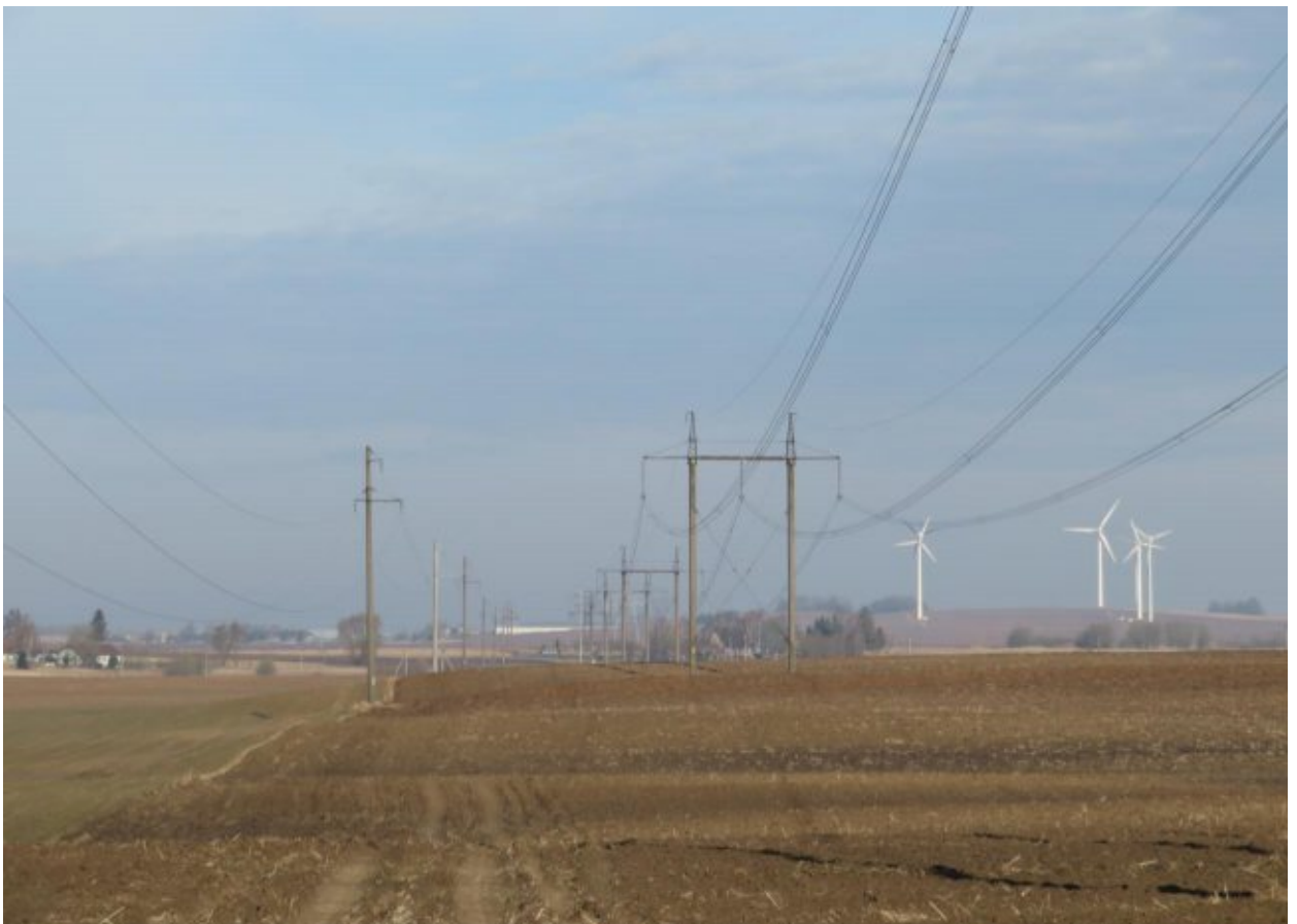
2 pav. Kraštovaizdyje dominuoja 330 kV ir 35 kV orinės elektros perdavimo linijos ir atramos. Vėjo elektrinės tampa subdominantėmis/ kraštovaizdžio akcentais
