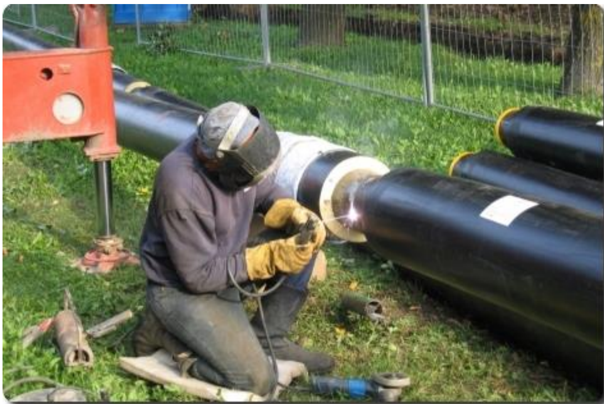
2 pav. Šilumos tiekimo vamzdžių suvirinimas. Šaltinis: dev.klenergija.lt
