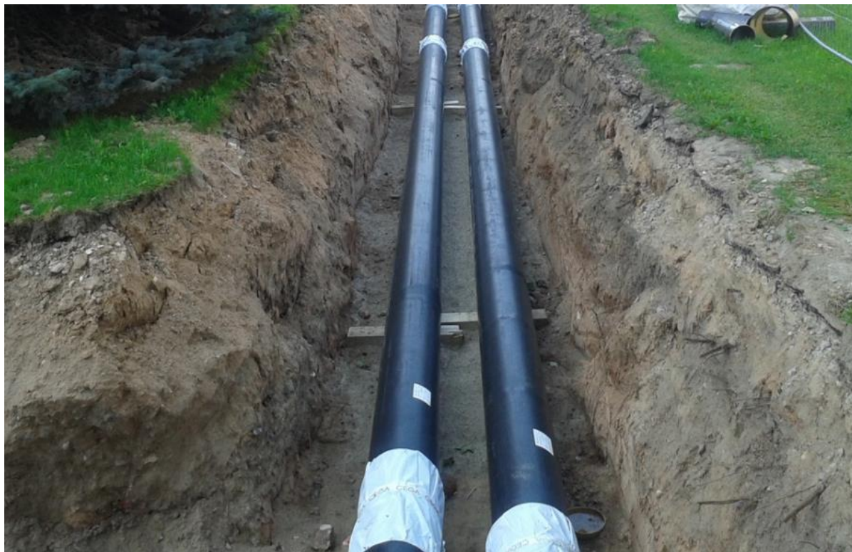
4 pav. Šilumos tiekimo bekanalio vamzdyno klojimas tranšėjoje pavyzdys. Šaltinis: jp.lt
