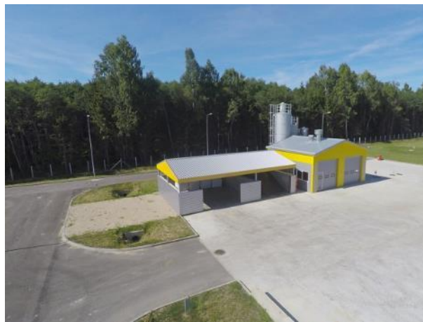
PA stabilizavimo įrenginiai
