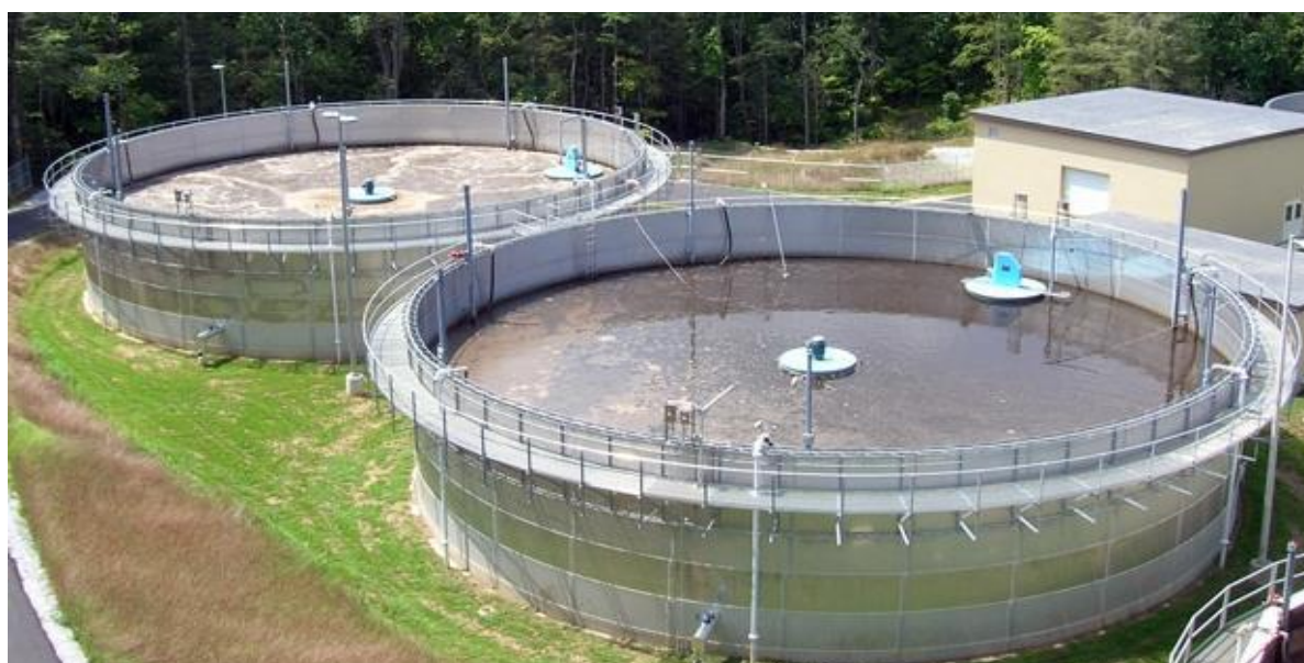
4 pav. Aeracinės oro sklaidos sistema: diskinių difuzorių ir aeracinio baseino pavyzdys
