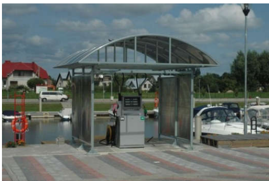
4.7.2 pav. UAB „Kintai“ laivų degalinė.
