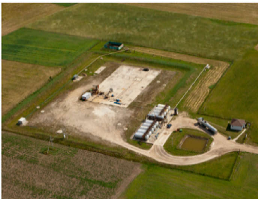
2.1.3 pav. Naftos gręžinio eksploatavimo ir naftos gavybos aikštelėse technologinės įrangos išdėstymas (analogiškas įrangos išdėstymas planuojamas ir Kintų objekte). Šaltinis: UAB "Minijos nafta" archyvas.
