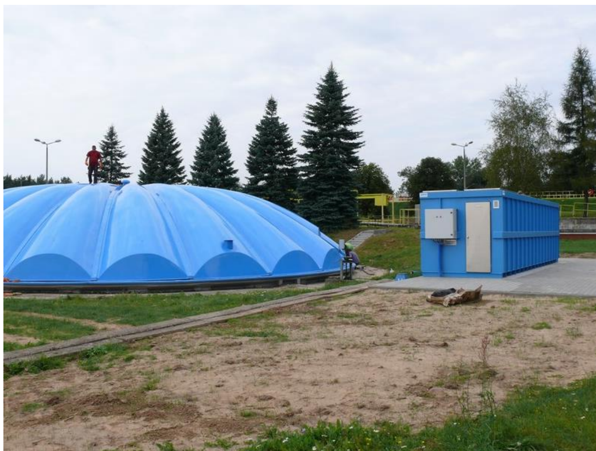
2 pav. Kvapų šalinimo sistemos įrenginių vaizdas nuotekų valykloje (Lenkija). Šaltinis: www.eko-partnerzy.pl
