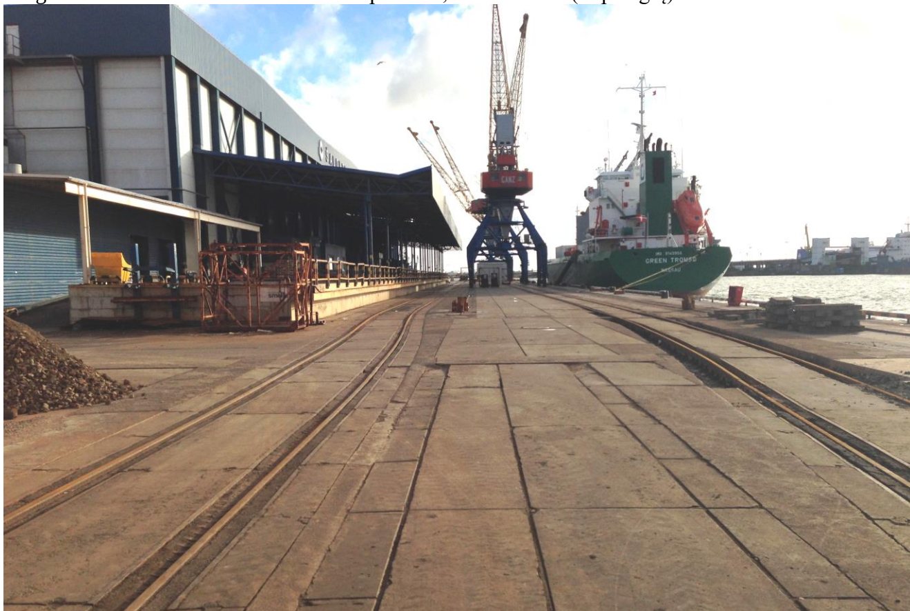
3.3.1 pav. Krantinė Nr. 105. Betoninių plokščių ir asfaltbetonio (prie bėgių) danga
