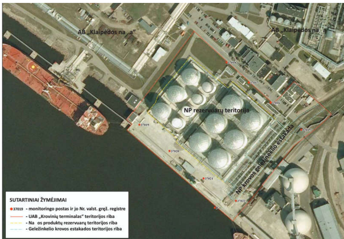
3.7.1 pav. Požeminio vandens monitoringo gręžiniai UAB „Krovinių terminalas“ teritorijoje (UAB „GEOTECH Baltic“, 2015).
