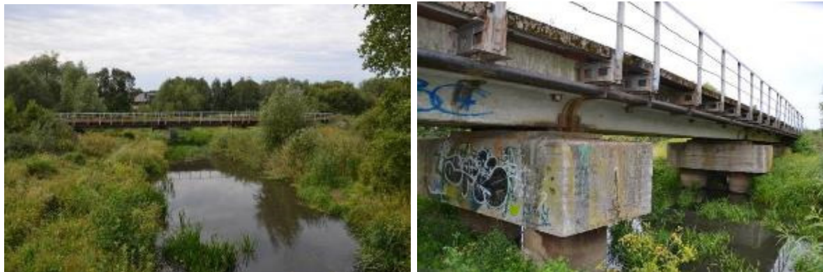
31 pav. Per Smeltalės upelį esantis geležinkelio tiltas bus rekonstruojamas. Tolesniuose projektavimo etapuose rekomenduojama užtikrinti, kad neapvalytos lietaus nuotekos nuo tilto nepatektų tiesiai į upelį kaip yra dabar
