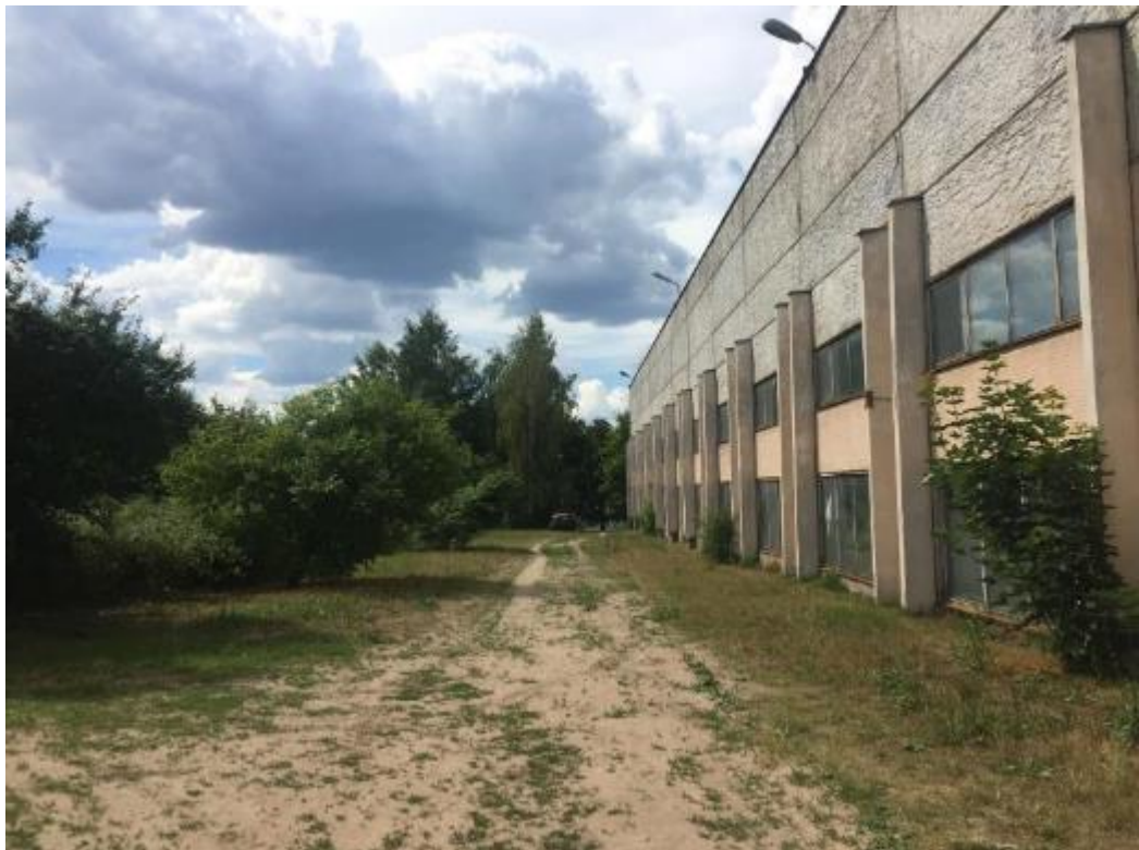
Pav. 3. Rekonstruojamas pastatas
