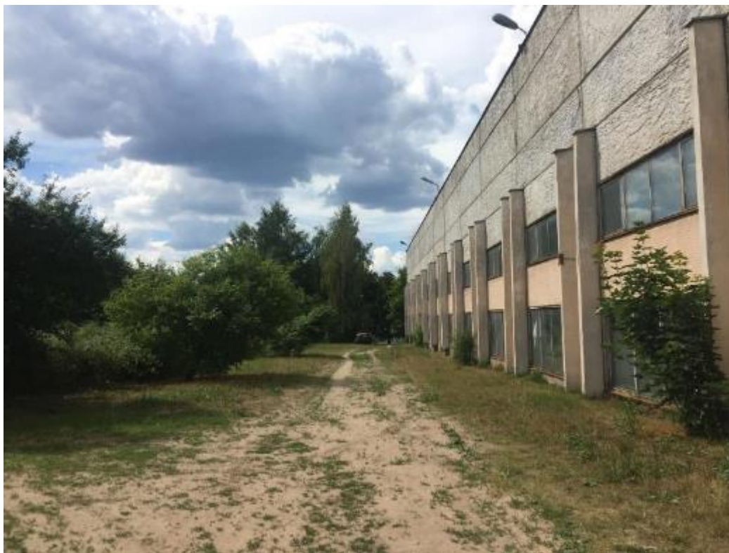
Pav. 3. Rekonstruojamas pastatas
