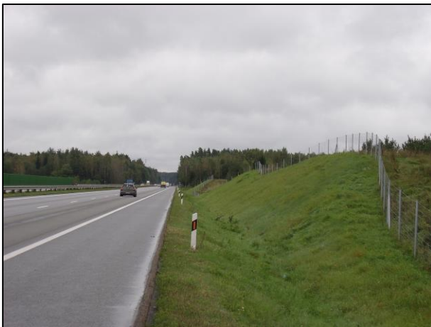
29 pav. Esamos laukinių gyvūnų apsaugos priemonės: tinklo tvora kelio kairėje pusėje ties 27,9 km (k.); požeminė perėja laukiniams gyvūnams ties 25,9 km
