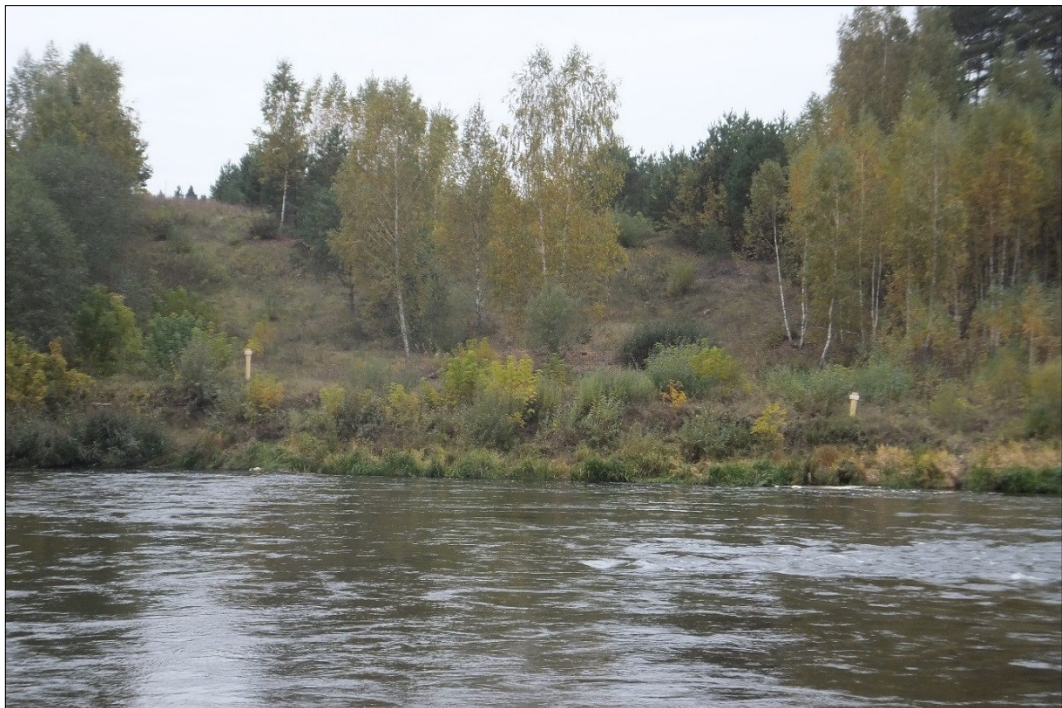
6.3.3. pav. Esamas dujotiekis per Neries upę.
