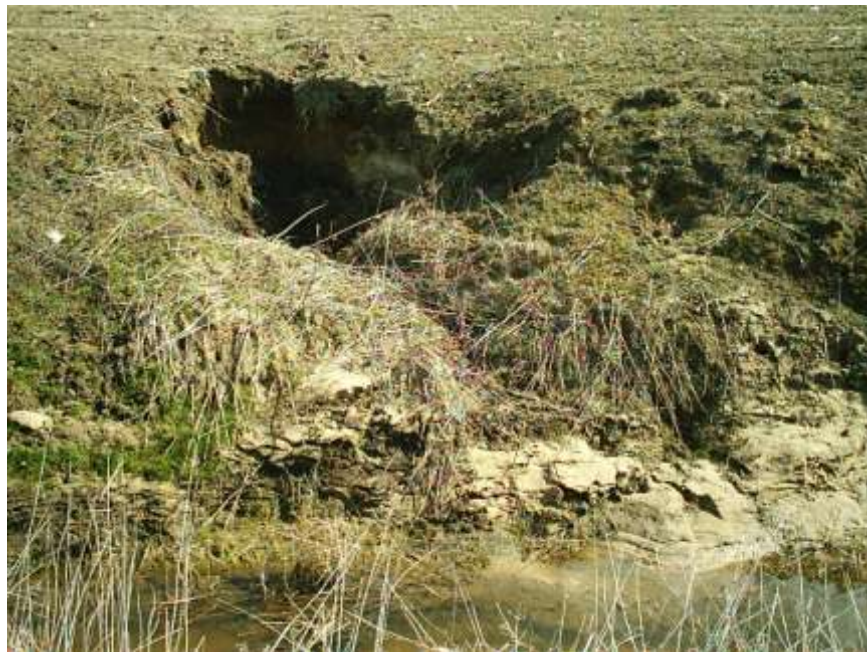
1.1.16 pav. Stambus erozinis darinys, susiformavęs Šerkšnio up. pagriovyje ir išeroduota apsauginė juosta Kėdainių r. (nuotr. V. Poškaus)
