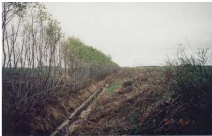
1.7.9 pav. Melioracinio griovio eksploatavimo pavyzdys dirbamoje žemėje (pietiniame šlaite leidžiama augti medžiams, o šiauriniame šlaite krūmai naikinami) (nuotr. V. Šaulio)
