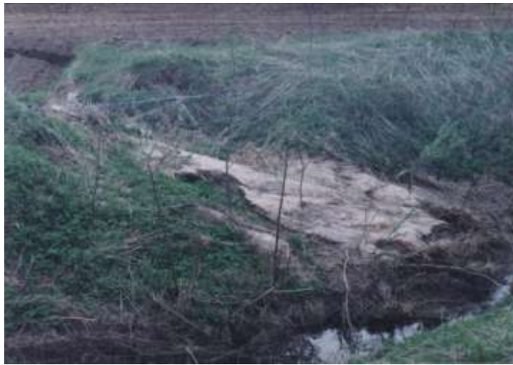
1.1.17 pav. Nešmenų sanakaupa griovyje ( nuotr. V. Poškaus )
