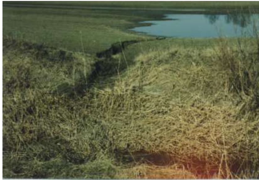
1.1.15 pav. Išgrauža šalia griovio Rimšulis-6 Radviliškio r. (nuotr. V. Poškaus)
