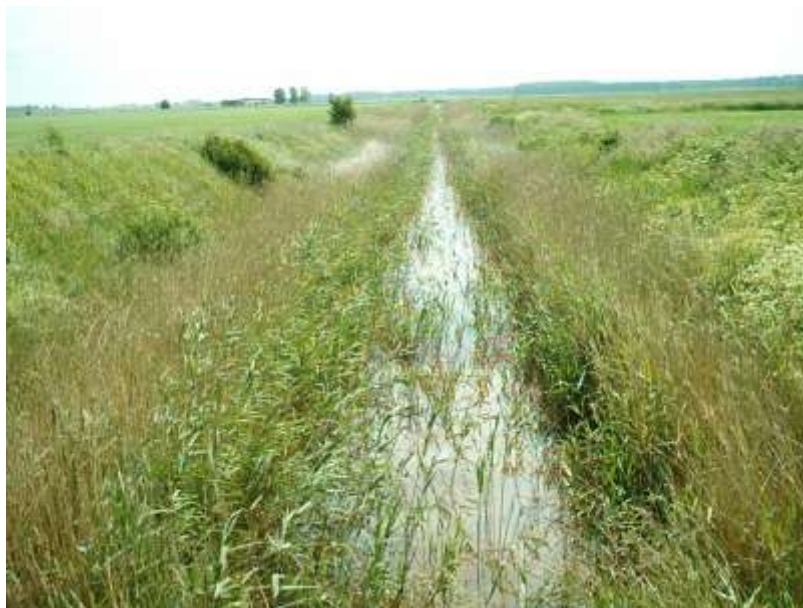
1.7.13 pav. Periodiškai valomas melioracinis griovys Brukšvų polderinėje sistemoje (nuotr. V. Poškaus)
