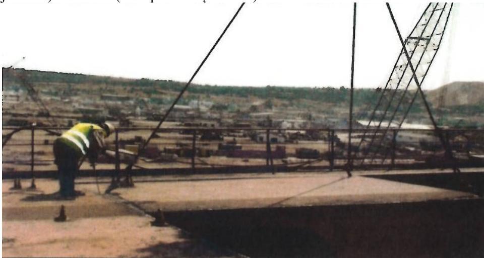
6 pav. Laivo korpuso stambios dalys paruošiamos perkėlimui (kranu) ant krantinės
