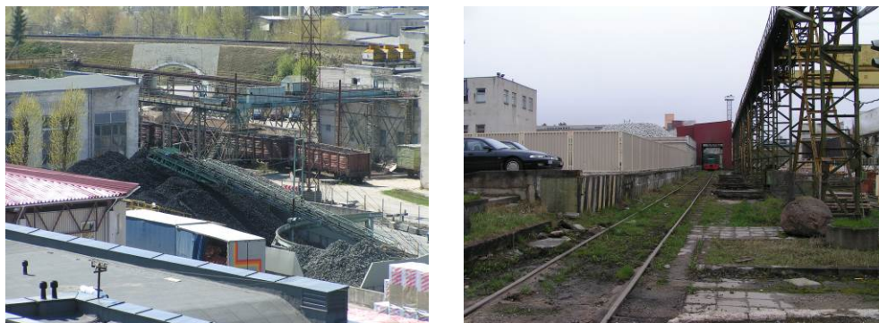
3 pav. Žaliavų aikštelė (kairėje) ir geležinkelio bėgių linija (dešinėje).
