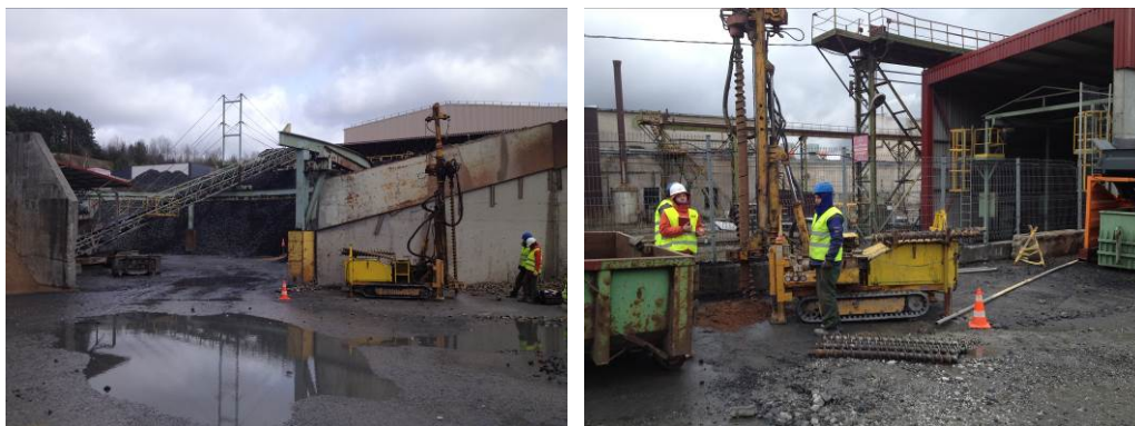
2 pav. Gręžinio Nr. P-29 (kairėje) ir P-30 (dešinėje) gręžimo darbai.
