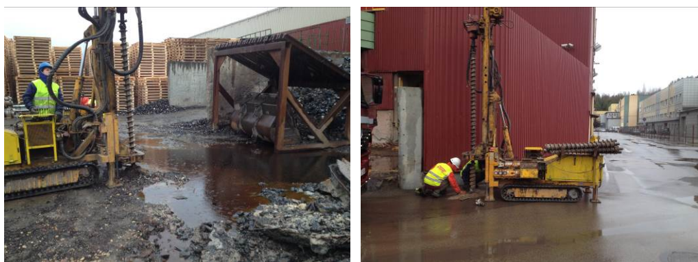
3 pav. Gręžinio Nr. P-31 (kairėje) ir P-32 (dešinėje) gręžimo darbai.
