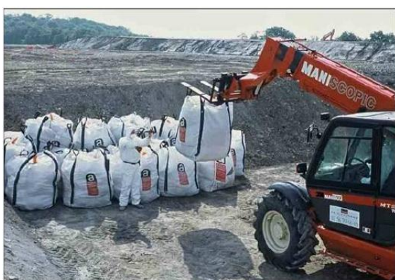
Pav. 4. Asbesto atliekų šalinimas ((Šaltinis:European commission, 2009)
